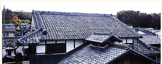
現況 主屋と台所の屋根（越屋根型の煙出し）
