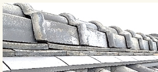
棟瓦は既設京箱棟瓦を再利用
