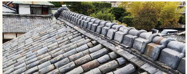
改修前の大屋根
