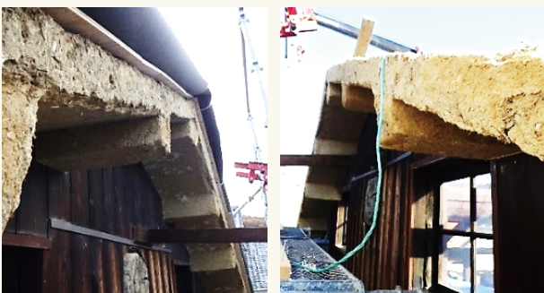
蟻羽の荒壁下地
