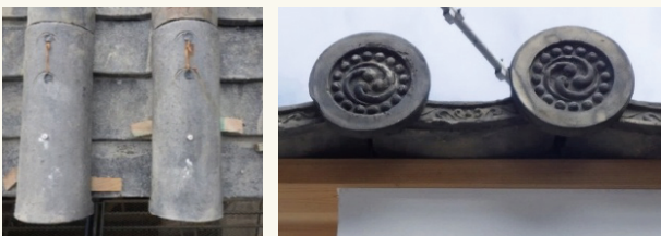
瓦葺き軒1段目軒丸瓦（SUSビスと銅線で固定） 一部鼠漆喰を使用しています。
