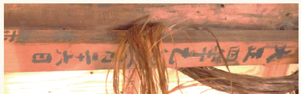
牛梁下面にあった改修時期の棟札
